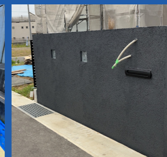
▲ 施工実績①
