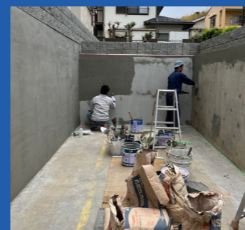
▲ 施工風景①
