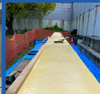
▲ 施工風景②
